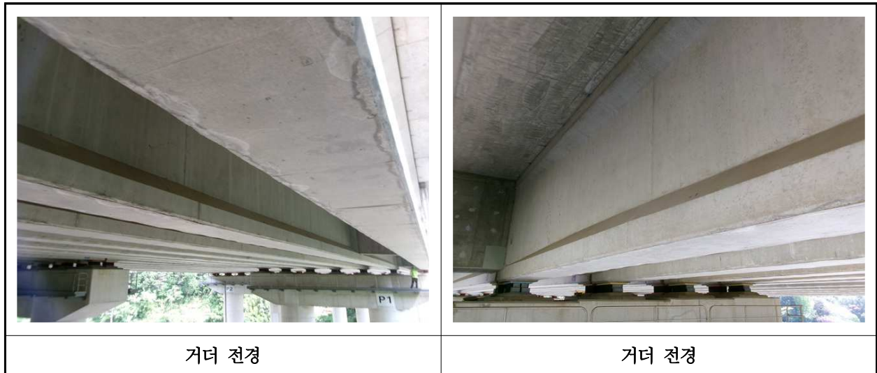
【사진 36.3.4】 거더 전경
