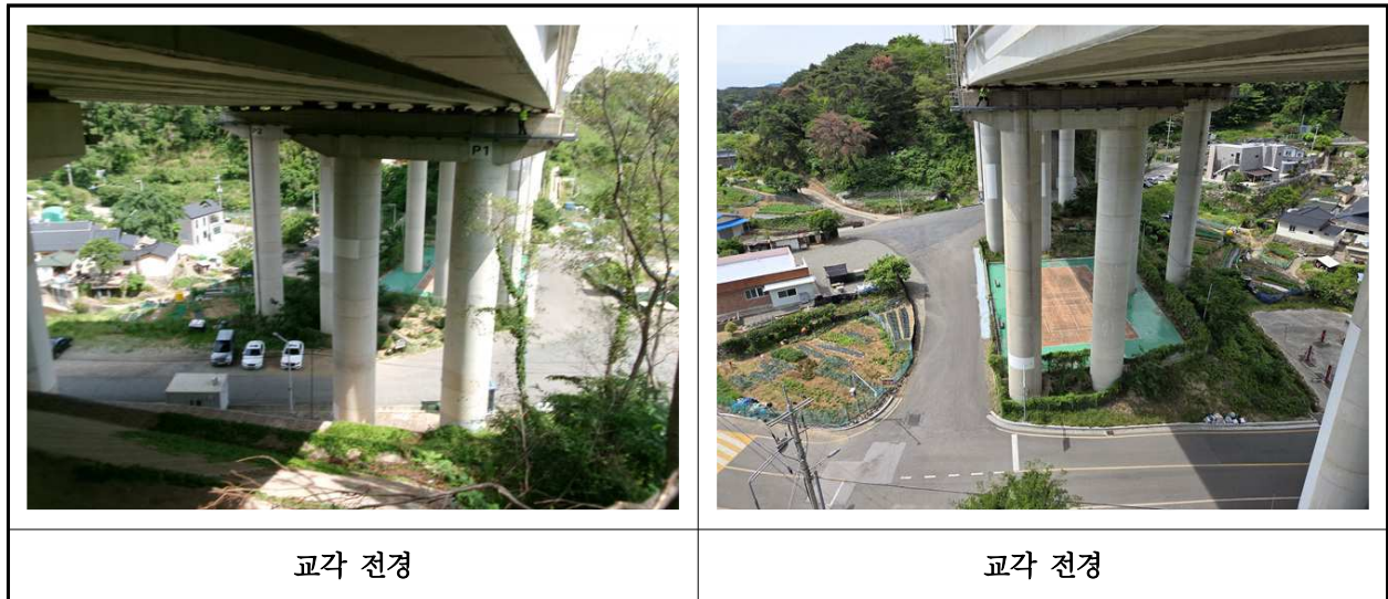
【사진 36.3.10】 교각 전경
