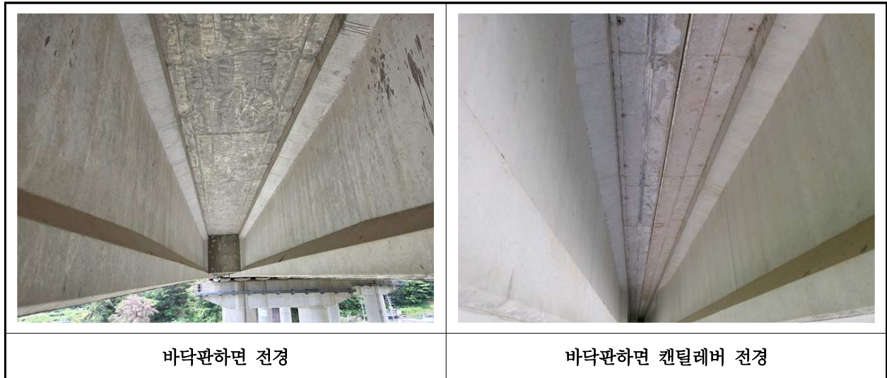
【사진 36.3.2】 바닥판하면 전경
