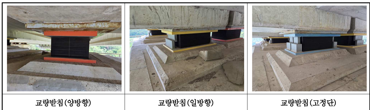
【사진 36.3.13】 교량받침 전경
