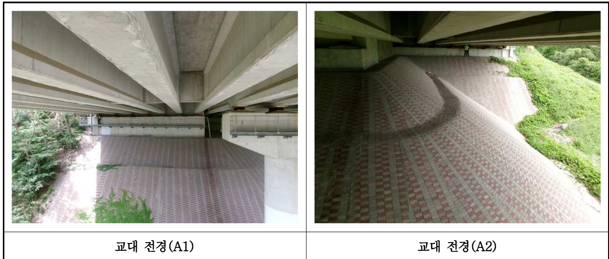
【사진 36.3.8】 교대 전경
