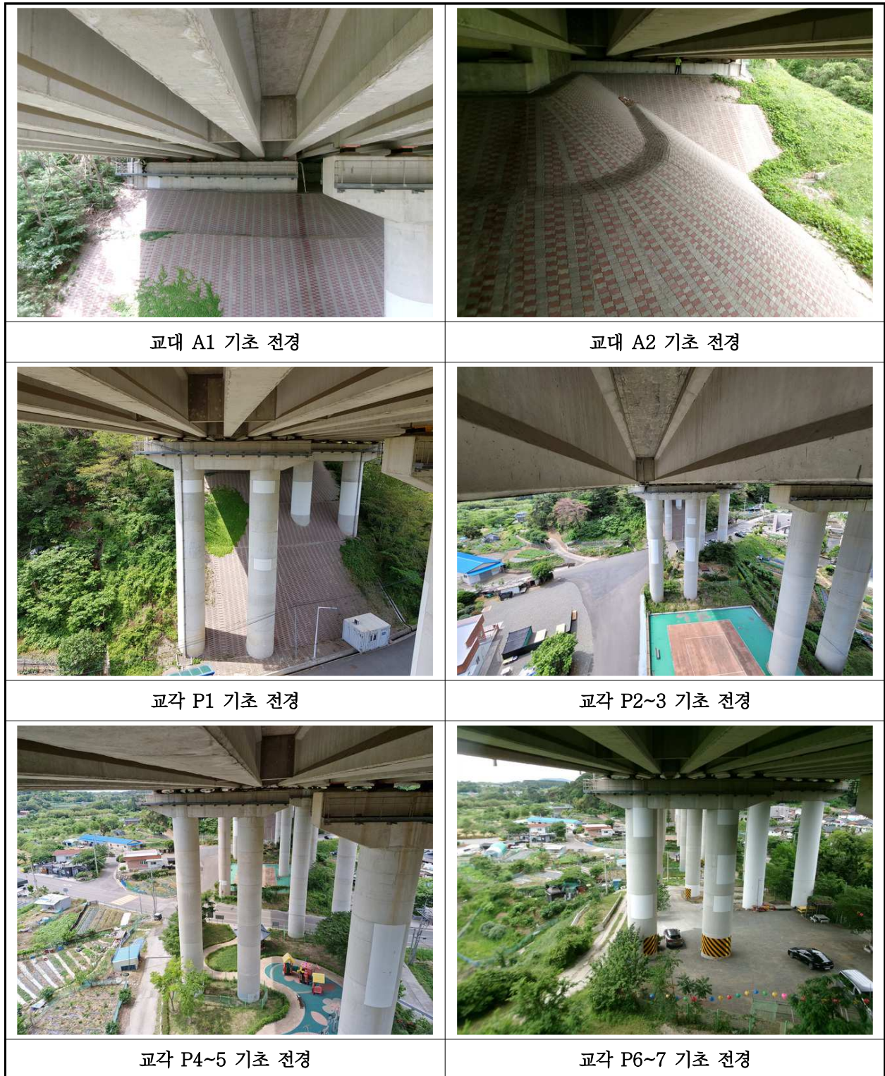
【사진 36.3.12】 기초 전경
