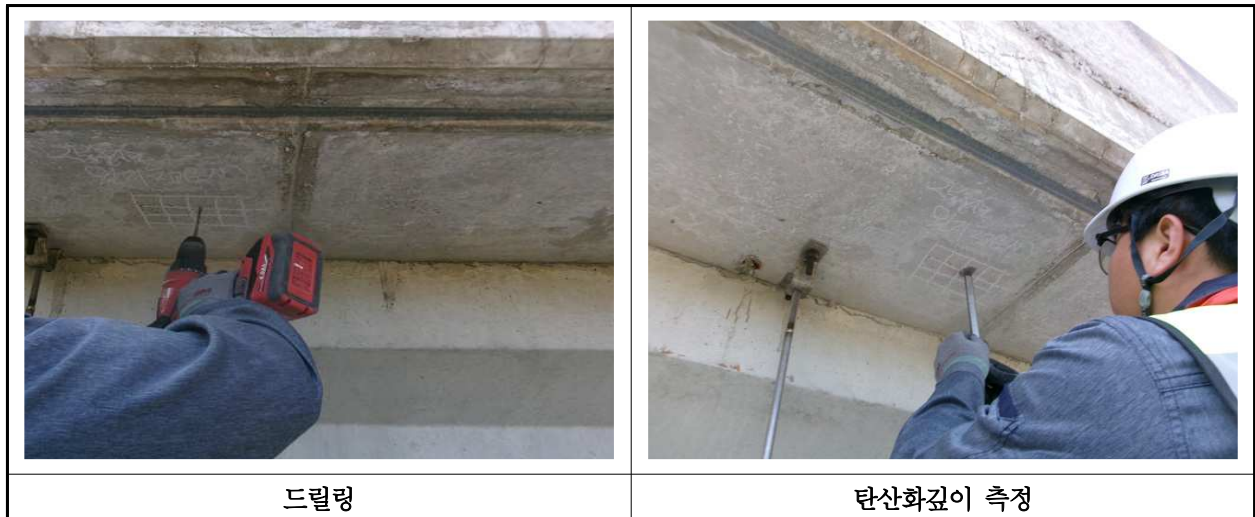
【사진 36.4.3】 탄산화 깊이 측정 현장사진
