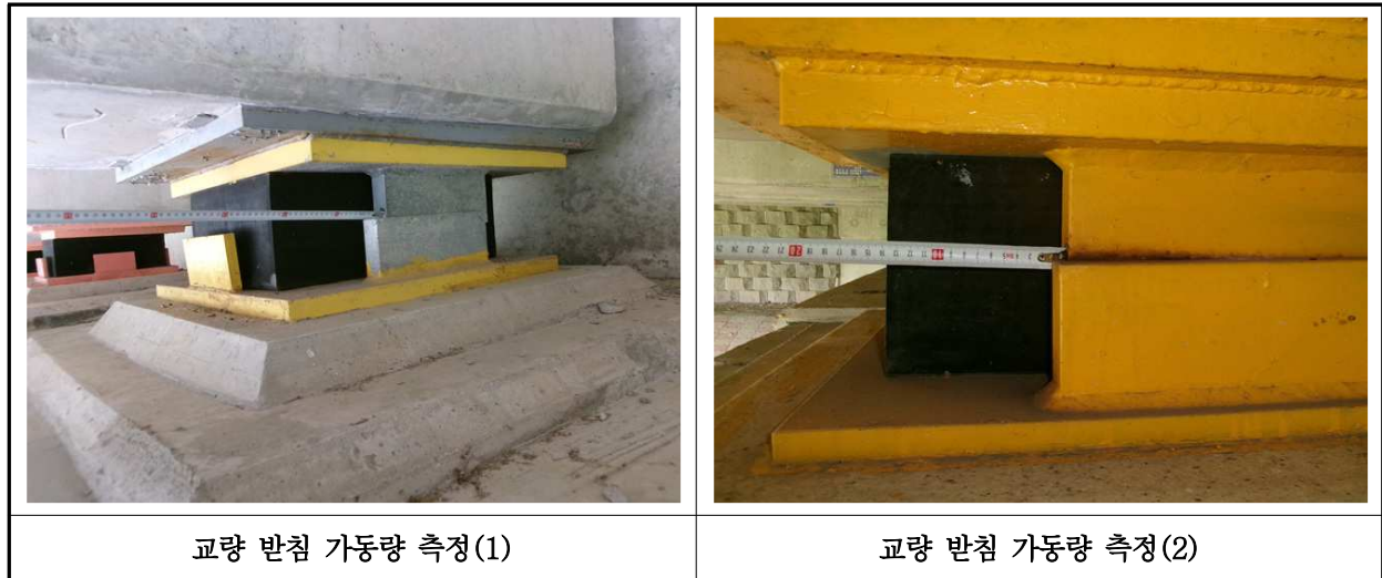
【사진 36.3.16】 교량받침 이동량 측정
