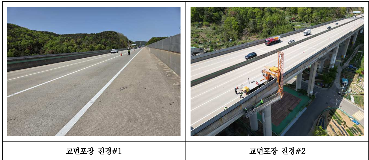
【사진 36.3.20】 교면포장 전경
