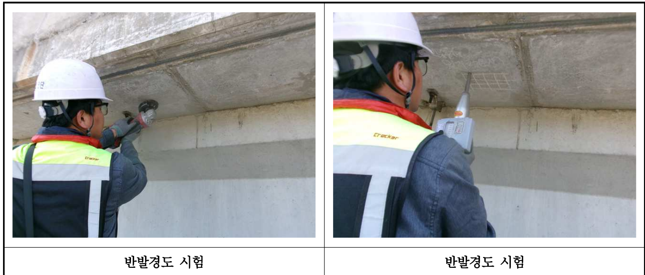
【사진 36.4.2】 반발경도시험 현장사진
