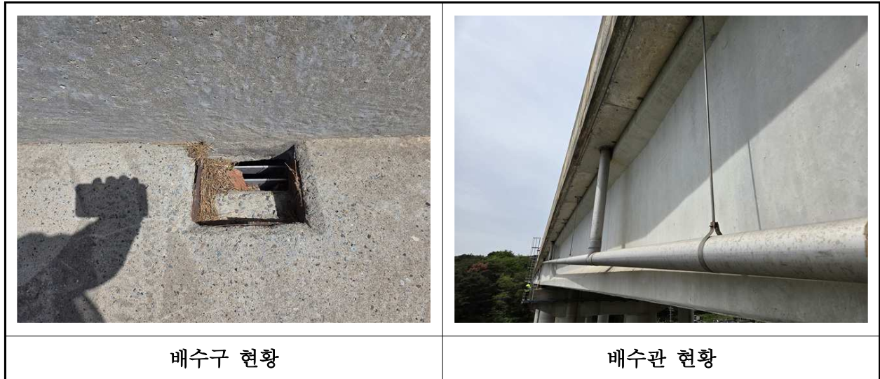
【사진 36.3.22】 배수시설 전경
