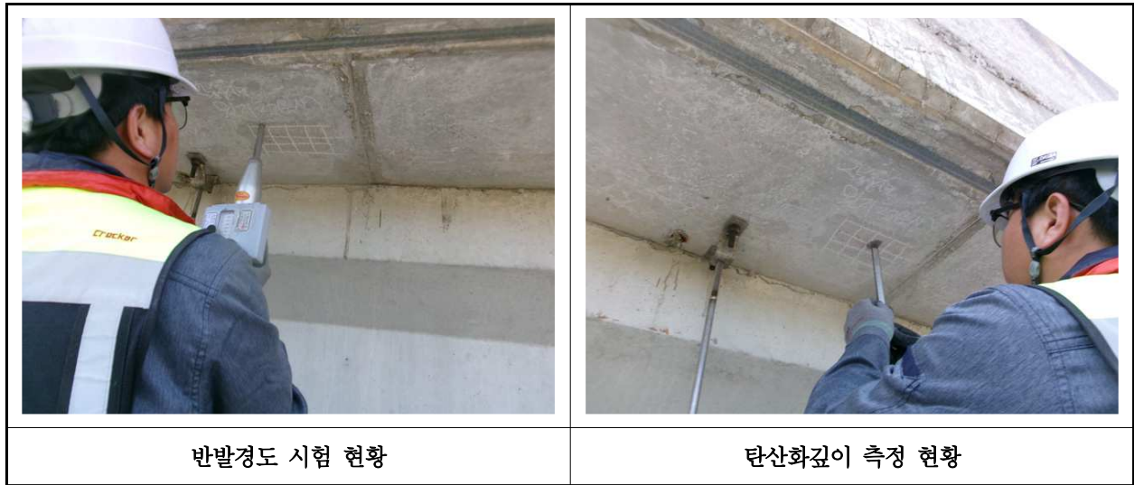
【사진 36.4.1】 콘크리트 내구성조사 현황
