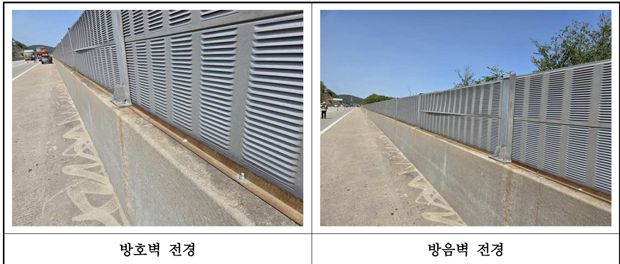
【사진 36.3.24】 방호벽 및 중분대 전경
